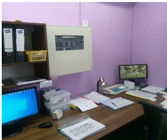
Instalace stávající ústředny EPS LOOP 500 v sesterně v patře budovy DS-A
